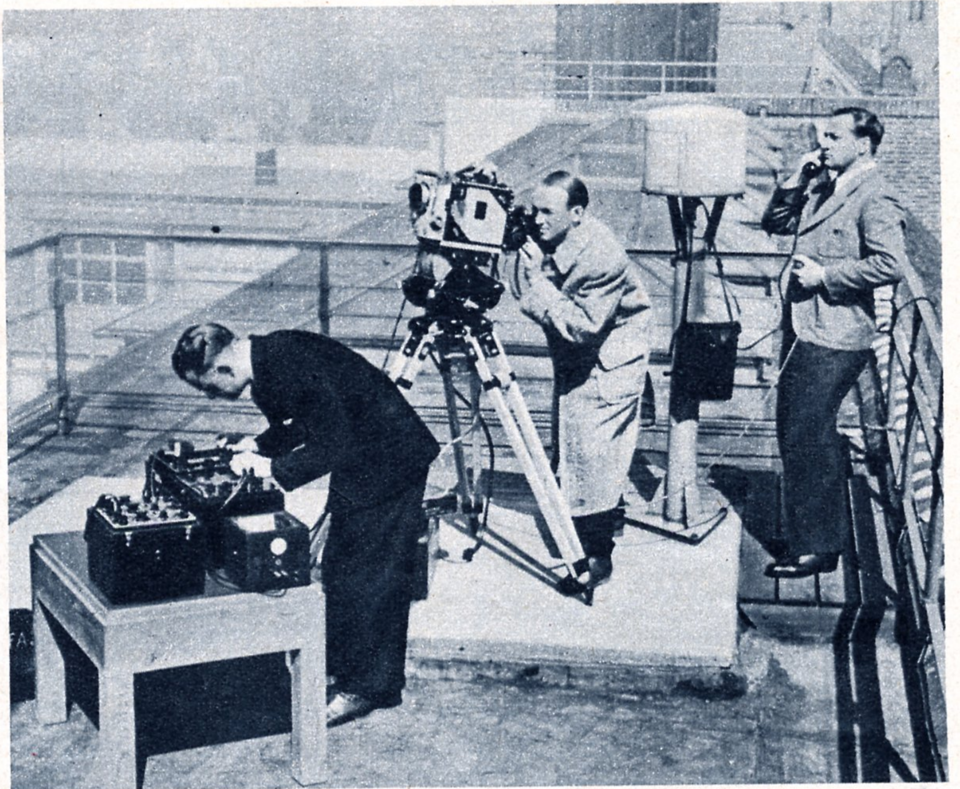
Über den Dächern der Großstadt. Eine Rekordmeßstation mit Oszillograph und Kontakt-Chronometer, Askania-Z-Kamera und Feldfernsprecher
